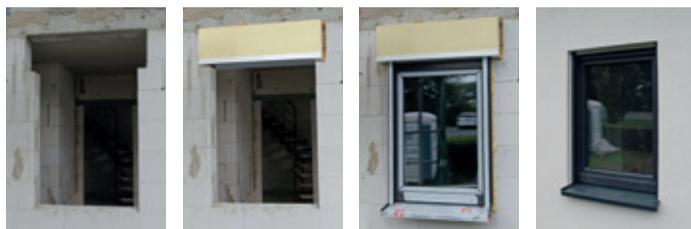
Alle von uns produzierten Rolladenkästen sind thermo-graphisch berechnet, zertifiziert und somit energetisch belastbar. Diese Nachweise sind für z. B. KfW-subventionierte Baumaß-nahmen wichtig! Zahlreiche Berechnungen finden Sie auf der Seite 11 oder im Internet unter [www.piening-rolladen.de/](http://www.piening-rolladen.de/) Einbausituationen
