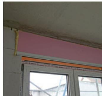
Bei Verblendmauerwerk muss die innere Frontplatte, und beim Wärmedämmverbundsystem die innere Frontplatte und die äußere XPS Blende den Vorschriften
